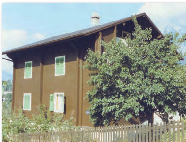
Unser Wohnhaus an der Napoleonstrasse, anfangs der Fünfzigerjahre vom Vater und Bruder Adolf erbaut.
