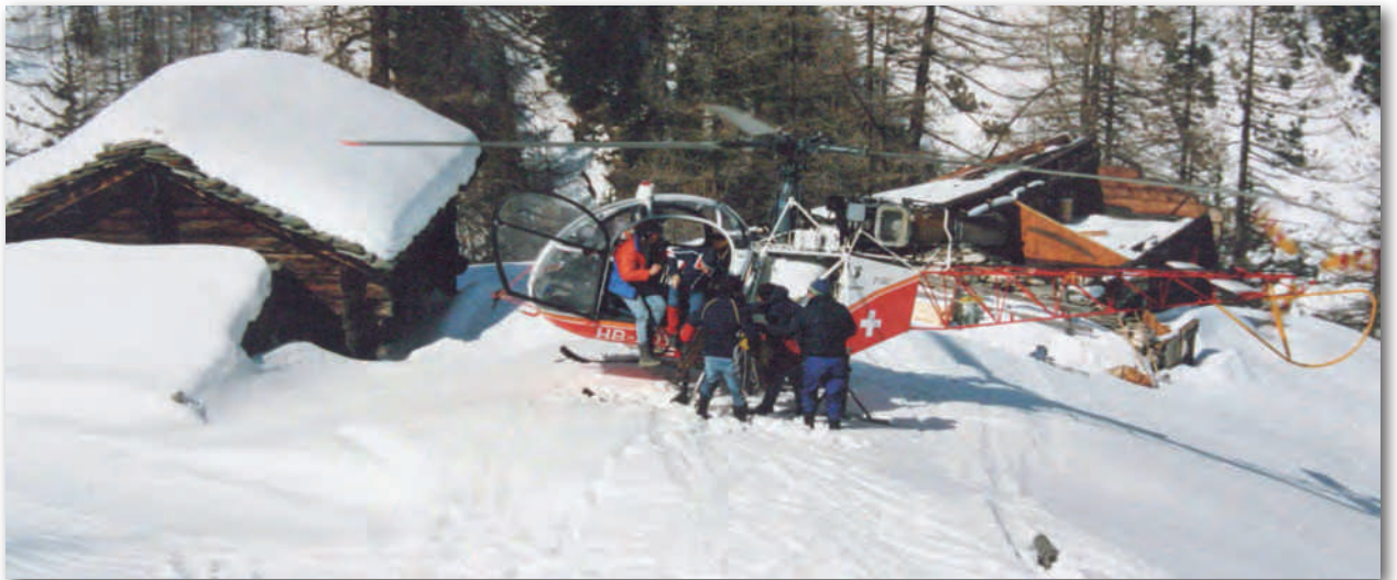
Am 27./28. Februar 1990 verwüstete der Sturm Vivian unsere Hütte im Obernesseltal. Am 10. März 1990 wurde sie notdürftig wieder instandgestellt. Das benötigte Material wurde per Helikopter eingeflogen.
