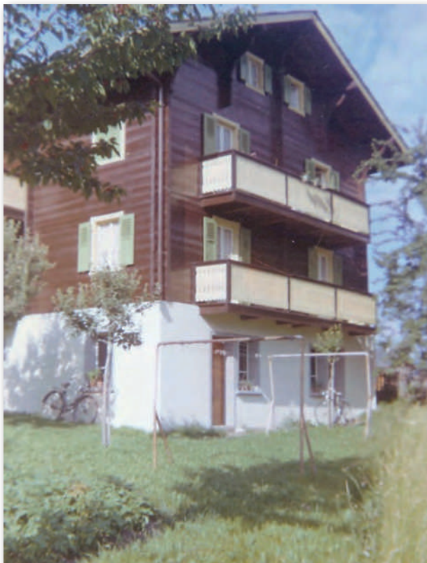
Nordansicht des Wohnhauses in der Napoleonstrasse.
